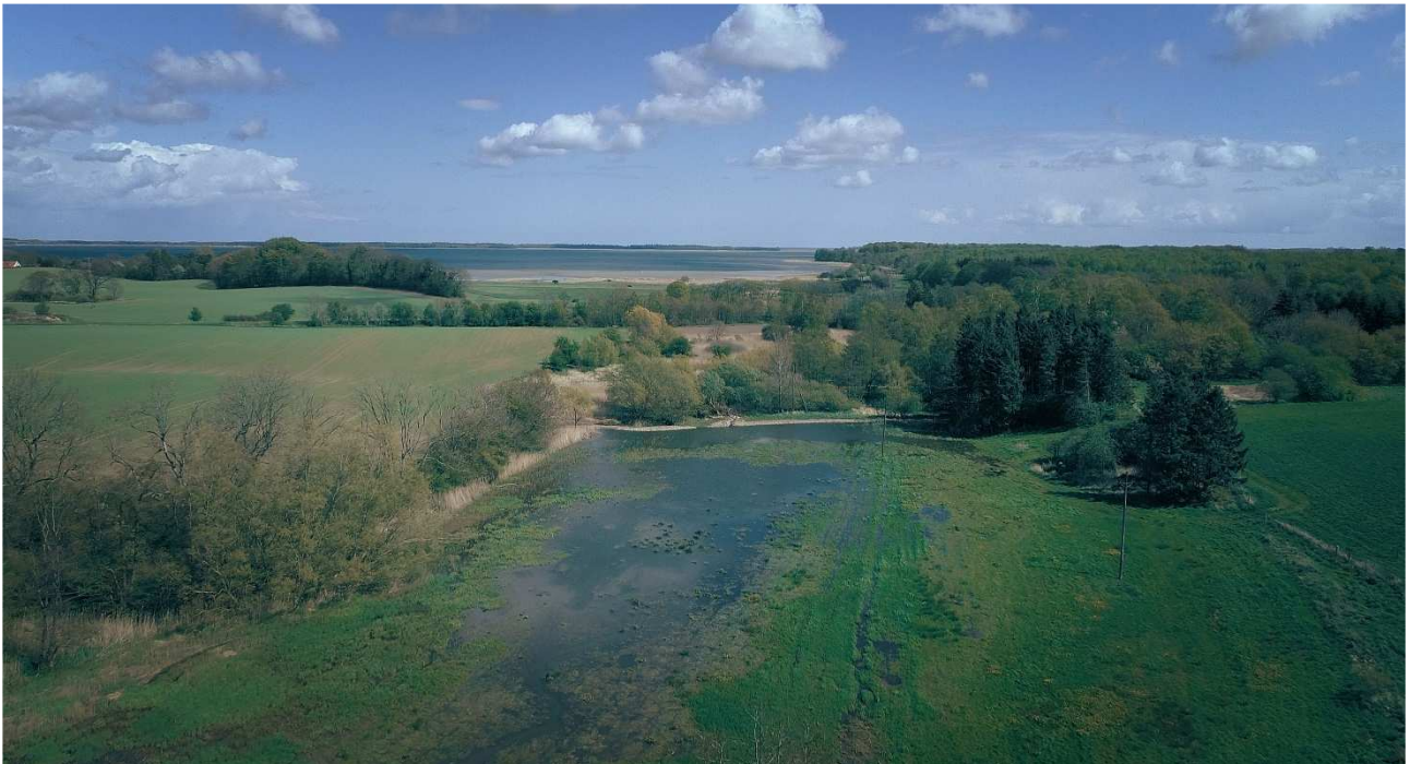
Geddefabrikken ved Hulebækken blev indviet foråret 2019.
